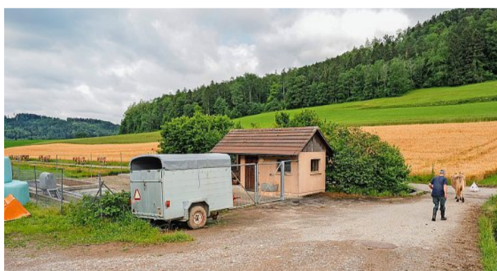
Die Tage der kleinen Kläranlage Unterschneit sind gezählt. Bald wird das Abwasser nach Elsau gepumpt. Foto: Enzo Lopardo
